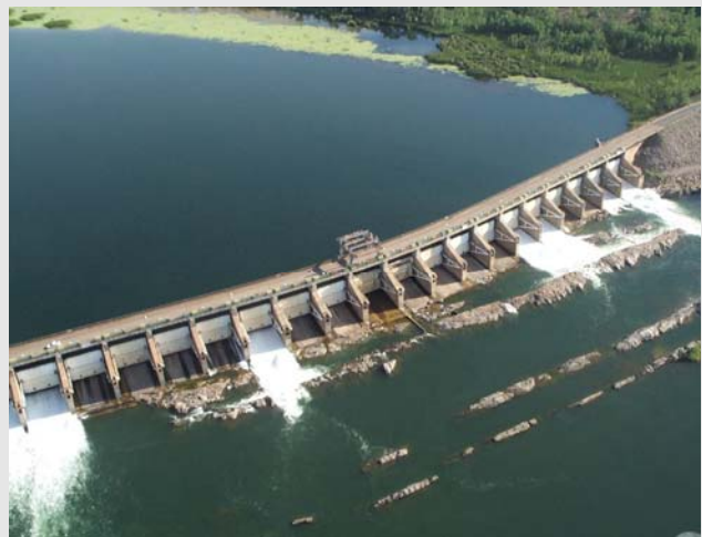
Diversion Dam - Kununurra
